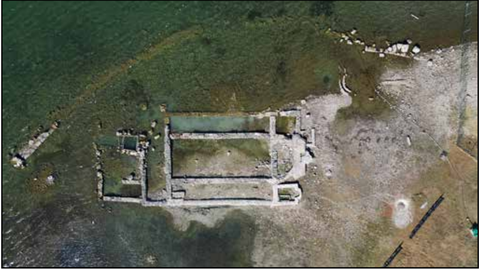
Resim 13: Bazilika Kilisenin güney beden duvarı, capping çalışmasından sonra.
